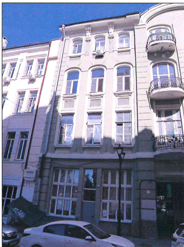
3. Фрагмент главного западного фасада литера А Объекта в уровне первого этажа.
