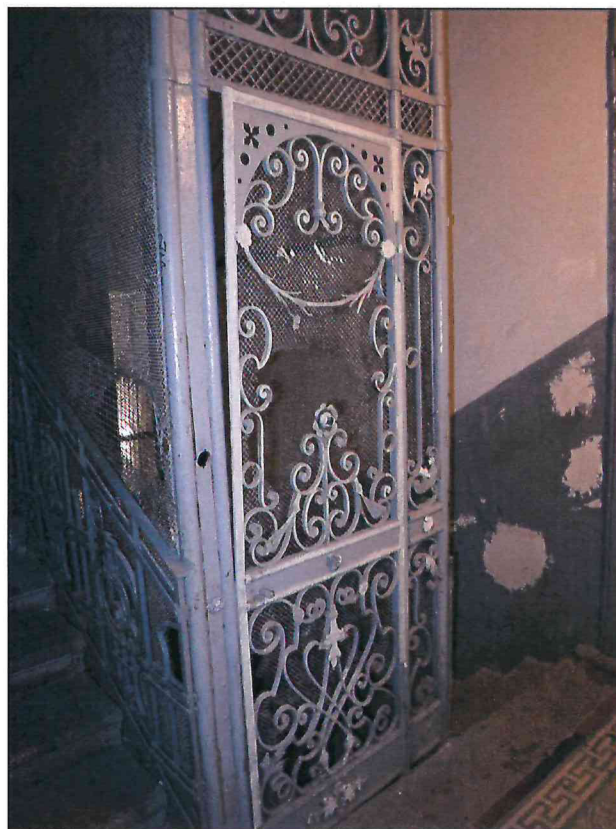
9. Кованая решетка шахты лифта на лестничной клетке в литере А Объекта.
