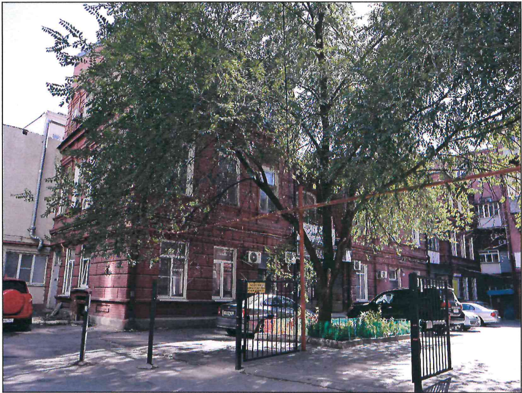
6. Вид литера В Объекта с северо-востока. Фото 2024 года.
