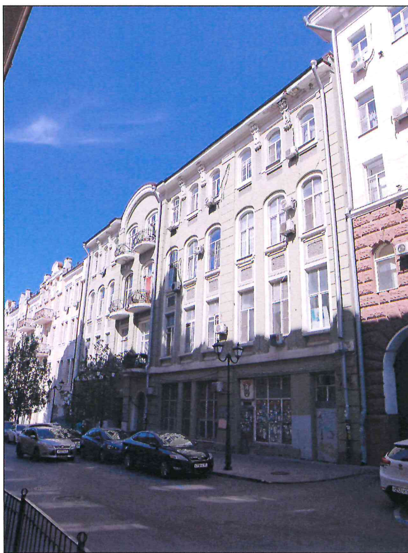
1. Вид литер А Объекта с юго-запада.
