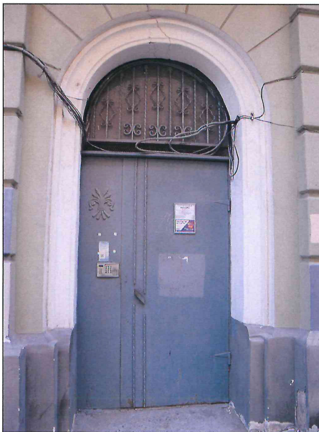
4. Фрагмент центральной раскреповки главного западного фасада литера А Объекта. Парадный вход.
