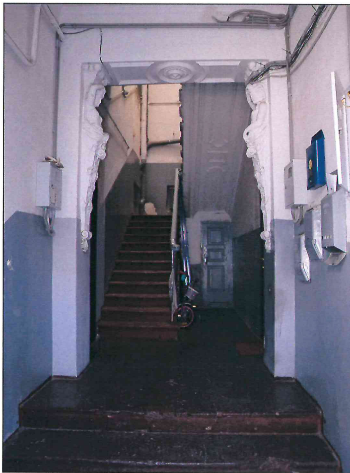
10. Вестибюль парадного входа литера В Объекта.
