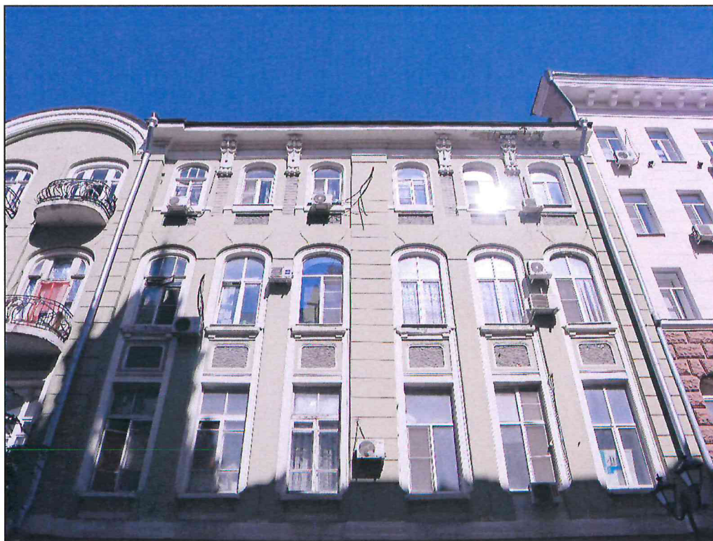
2. Фрагмент главного западного фасада литера А Объекта.
