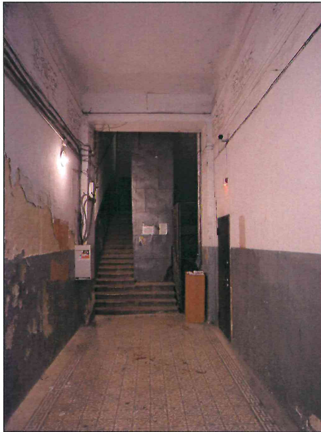
8. Вестибюль парадного входа литера А Объекта.
