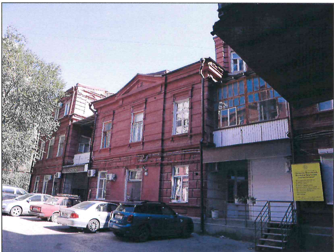
7. Дворовый северный фасад литера В Объекта. Фото 2024 года.
